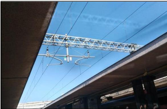
圖 107 義大利國鐵正線 OCS 系統裝置
