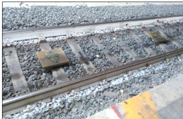
圖 108 義大利國鐵正線號誌系統裝置
