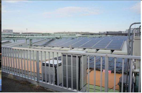
圖 22：森崎水再生中心設置太陽能板為淨水廠供電
